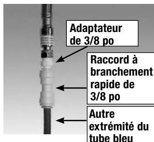
Étape 2 - Localisez le raccord à branchement rapide de 3/8 po x 3/8 po dans le sachet des pièces. Poussez le raccord sur l'adaptateur de tige de 3/8 po fixé au tuyau du robinet jusqu'à ce qu'il soit bien installé.
