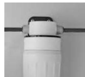
Étape 2 - Connectez le tube bleu de 3/8 po provenant de la vanne d'arrêt d'équerre du côté gauche de l'unité de filtration (IN) en poussant le tube fermement dans le raccord à branchement rapide. Connectez le tube bleu de 3/8 po provenant du boyau d'arrivée du robinet du côté droit de l'unité de filtration (OUT) en poussant le tube fermement dans le raccord à branchement rapide.
