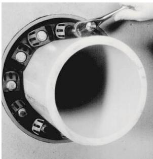
Вручную затяните болты с помощью гаечного ключа. Не затягивайте болт более чем 4 оборота за один раз. Затягивайте болты перекрестно или последовательно, пока все болты не будут равномерно затянуты. Повторите эту процедуру через пару часов, чтобы обеспечить долгосрочное напряжение болтов.
