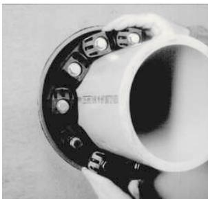
Вставьте уплотнение Micro Seal в кольцевидную полость между трубой и стеной. Для звеньев большого размера, разместите вставки болтов на 6 часов и работайте с обеих сторон, вверх по направлению к позиции 12 часов в кольцевом пространстве.
